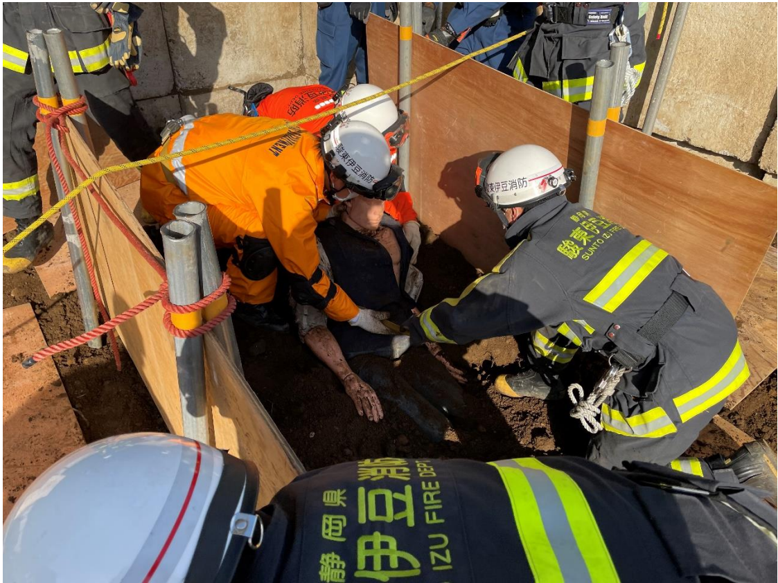
令和2年12月 トレンチレスキュー（土砂埋没救助）
