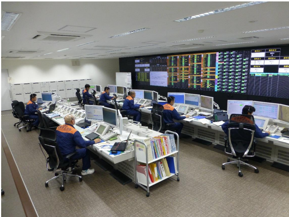
消防指令センター 高機能消防指令システム (Ⅲ型)
