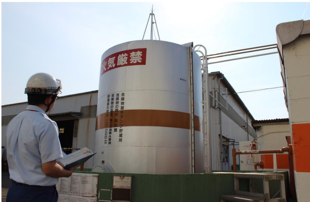
【屋外タンク貯蔵所の検査の様子】
