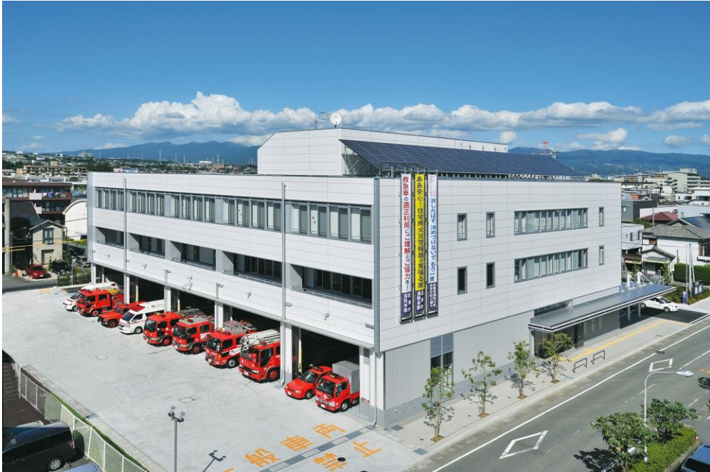
沼津市消防本部庁舎
