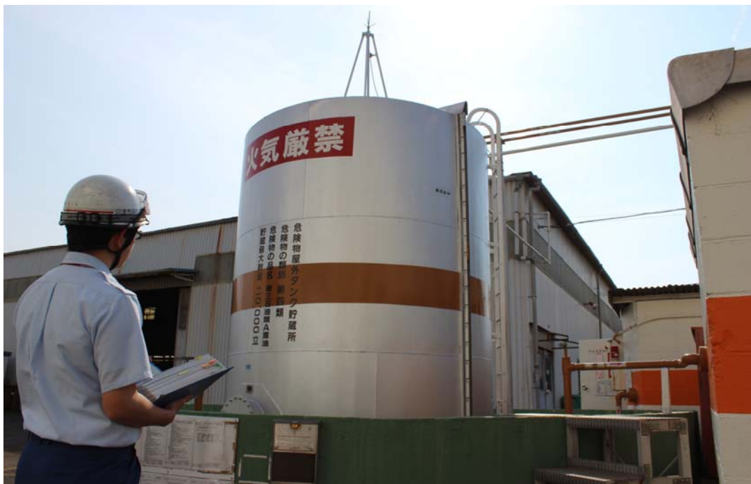
【屋外タンク貯蔵所の検査の様子】
